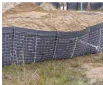
一体性比較実験状況
